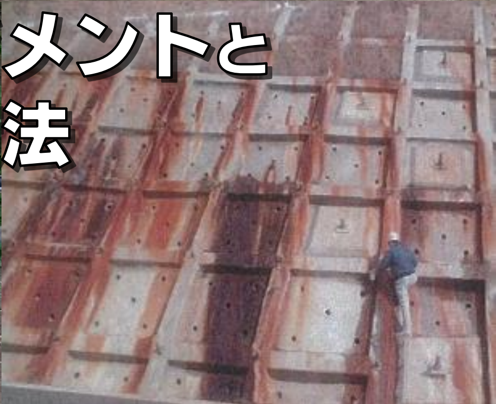
<写真上>掘削発生土（岩砕）の遮水工封じ込め施工例、<写真左>実現象再現溶出試験の例（寒地土研式雨水曝露試験）、<写真右>酸性水発生により変色した法面
